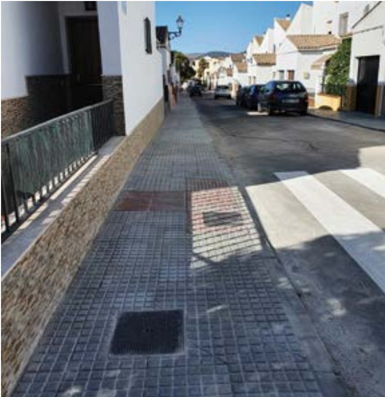
Estado de la calle Antonio Machado tras la remodelación
