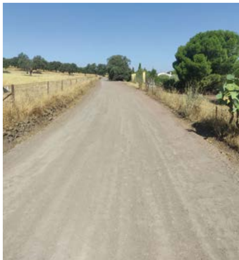
Estado del camino una vez terminadas las actuaciones
