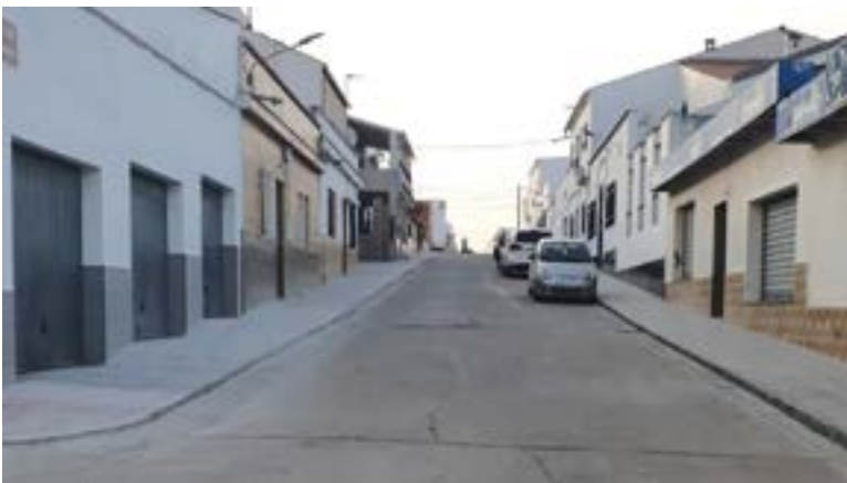
Estado de la calle tras su remodelación
