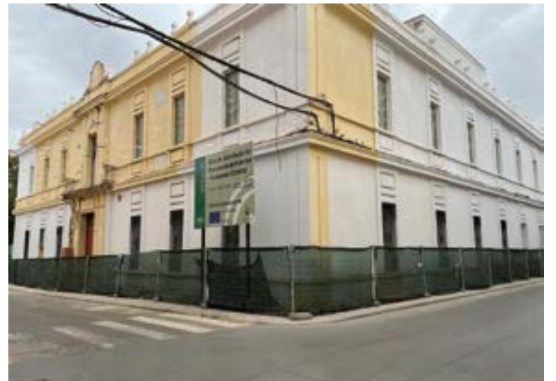
Estado actual de las instalaciones del Ayuntamiento
